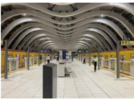
銀座線渋谷駅(建築家内藤廣設計):M形フレームでスカイデッキを支える
